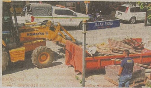
Kerja-kerja merobohkan satu struktur pengiklanan haram oleh DBKL di Jalan Riong Off Jalan Bangsar, Kuala Lumpur pada Selasa.
