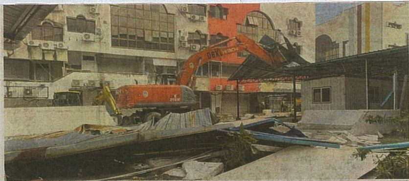
Sebahagian premis Insaf Malaysia di Taman Setiawangsa dirobohkan DBKL.
