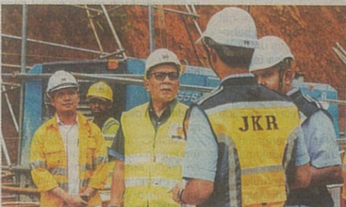
Exco Infrastruktur dan Pertanian Selangor, Datuk Ir Izham Hashim mengadakan lawatan ke tapak projek pemulihan cerun di Jalan Genting Peras Seksyen 32.460, Hulu Langat untuk meninjau kemajuan kerja-kerja pembaikan cerun.
