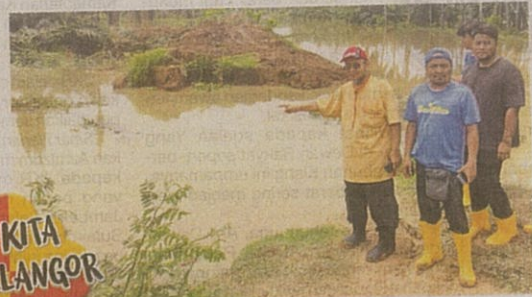
Penduduk menunjukkan keadaan ban pecah di lembangan Sungai Buloh hingga mengundang kejadian banjir.
