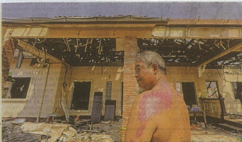
PENDUDUK, Mohamad Johar Misri menunjukkan kesan melecur pada belakang badan dan rumah sewanya yang musnah akibat letupan paip gas di Putra Heights di Kampung Kuala Sungai Baru, semalam. - UTUSAN/FARIZ RUSADIO
