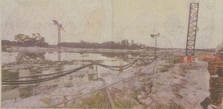
KEADAAN air yang memenuhi tapak projek pembinaan loji rawatan air yang berkedalaman 19 meter semalam.
