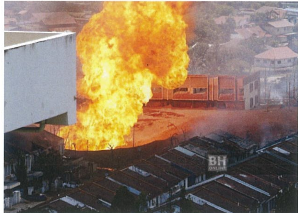
Letupan saluran paip gas sepanjang 500 meter yang menyebabkan kebakaran di Jalan Putra Harmoni, Putra Heights, 1 April lalu - Fail NSTP/EIZAIRI SHAMSUDIN
