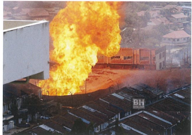
Letupan saluran paip gas sepanjang 500 meter yang menyebabkan kebakaran di Jalan Putra Harmoni, Putra Heights, 1 April lalu. - Fail NSTP/EIZAIRI SHAMSUDDIN
