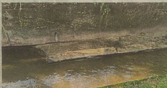
Kerja pembersihan keseluruhan longkang bagi mengelak aliran berminyak memasuki Sungai Gong.
