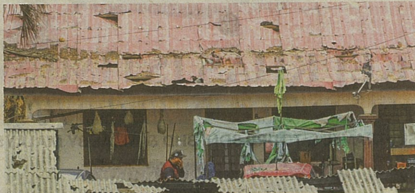
KEADAAN rumah yang terjejas akibat kebakaran saluran paip gas ketika dirakamkan pada tinjauan di Kampung Kuala Sungai Baru, Subang Jaya, Selangor, semalam.
