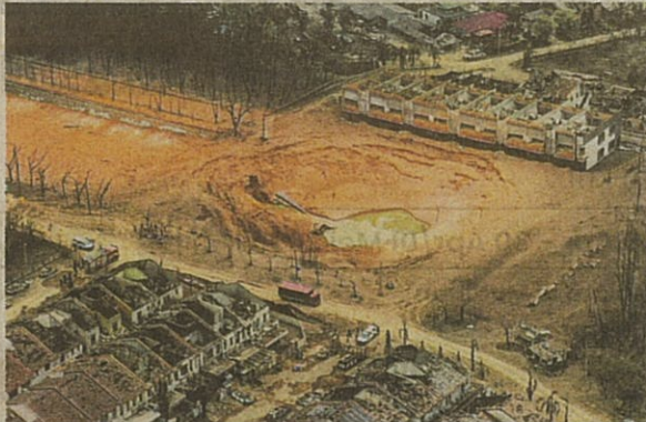
Kedaaan di kawasan kebakaran melibatkan kebocoran saluran paip gas di Jalan Putra Harmoni, Putra Heights baru-baru ini.
