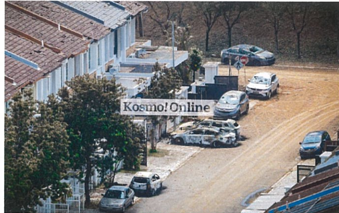
ANTARA kediaman dan kenderaan yang rosak akibat kebakaran paip gas di Putra Heights, baru-baru ini.
