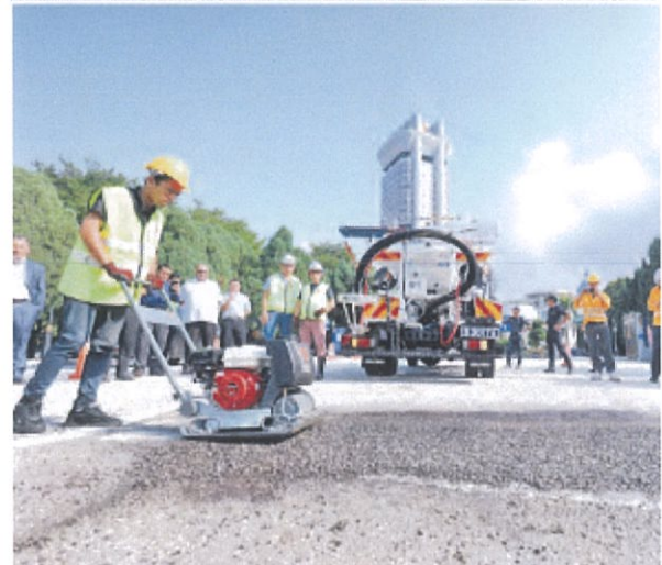
Demonstrasi menampal jalan menggunakan Jentera Baik Jal Jalan Jetpatcher Infrasel pada 10 September 2024
