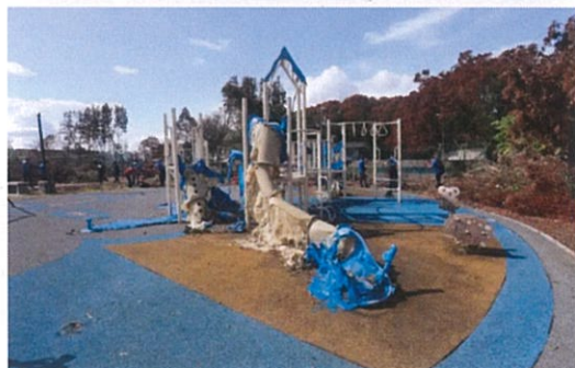
Taman permainan cair akibat kebakaran saluran paip gas di Putra Heights, Subang Jaya pada 13 April 2025. Foto AHMAD ZAKKI JILAN/MEDIA SELANGOR
