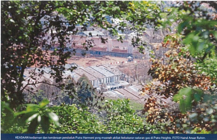
KEADAN kediaman dan kenderaan penduduk Putra Harmoni yang musnah akibat kebakaran saluran gas di Putra Heights. FOTO Hainal Anwar Rahim.
