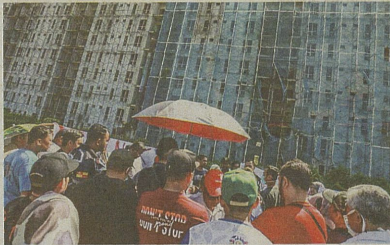
DUA projek Rumah Selangorku di Morib masih gagal disiapkan menyebabkan lebih 500 pembeli belum dapat menduduki rumah tersebut.
