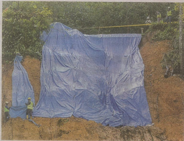
Penutupan runtuhan cerun menggunakan kanvas antara langkah mitigasi jangka pendek yang telah diambil oleh pihak berkuasa.
