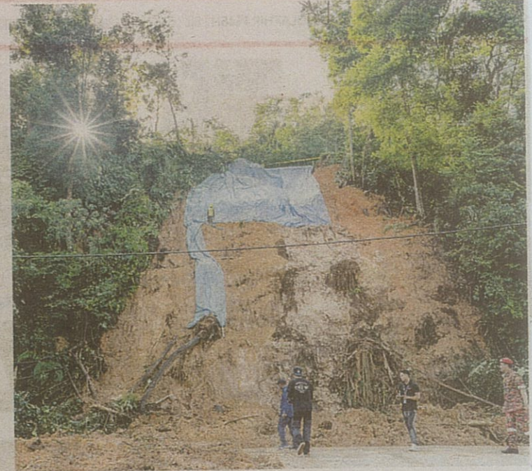
Keadaan tanah runtuh di Jalan E6, Taman Melawati ketika tinjauan pada Rabu.
