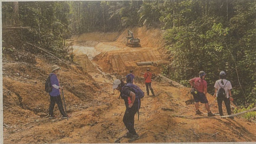
AKTIVIS alam sekitar meninjau kawasan hutan yang ditebang bagi pembinaan jalan menghubungkan Puncak Perdana dengan Setia Alam di Shah Alam, Selangor. - IHSAN AKTIVIS SACF
