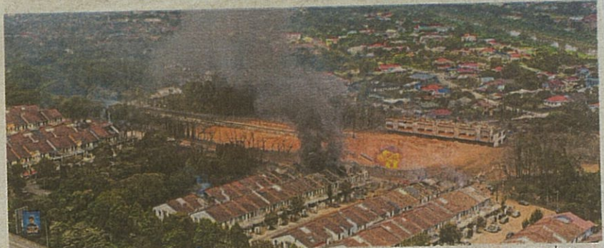
Kebakaran saluran paip gas di Jalan Putra Harmoni Putra Heights mulai reda pada jam 2.30 petang, semalam. (Foto BERNAMA)
