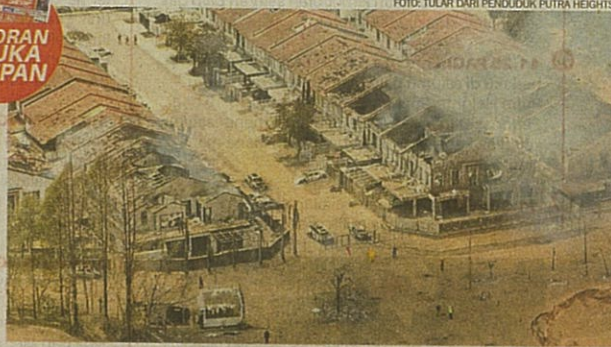
Keadaan rumah di kawasan berhampiran yang terkesan akibat kebakaran saluran paip gas di Jalan Putra Harmoni, Putra Heights pada Selasa.
