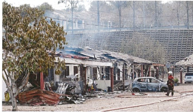
Kedudukan kenderaan dan kediaman yang terbakar dan mencair di Kampung Tengah dan Kampung Kuala Sungai Baru akibat kebakaran membabitkan saluran paip gas sepanjang 500 meter di Jalan Putra Harmoni, Putra Heights. - Foto NSTP/Elzairi Shamsudin
