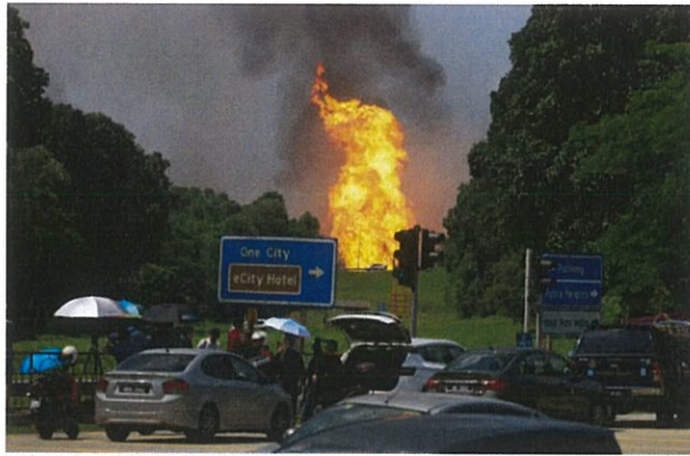
Pandangan dari Persiaran Harmoni kebakaran saluran paip gas di Jalan Putra Harmoni Putra Heights, Subang Jaya pada 1 April 2025. Foto NUR ADIBAH AHMAD IZAM/MEDIA SELANGOR
