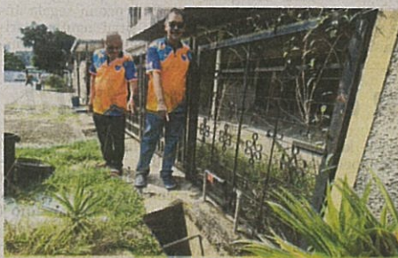
MOHD Yusof (kanan) menunjukkan longkang yang sempit tidak dapat menampung hujan lebat mengakibatkan banjir kilat.
