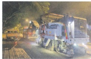
Kerja kerja "milling" sebelum kerja turapan bermula
