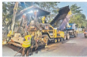
Kerja kerja turapan yang dijalankan oleh Infrasel
