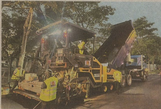
Kerja-kerja turapan sedang dijalankan oleh Infrasel.
