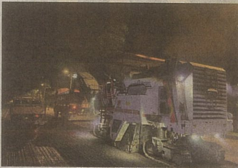
Kerja-kerja 'milling' sebelum kerja turapan bermula.
