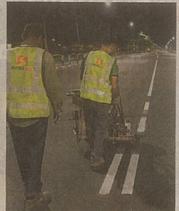
Kerja-kerja membuat garisan jalan sedang dilaksanakan di Jalan Raja Chulan, Sabak Bernam.
