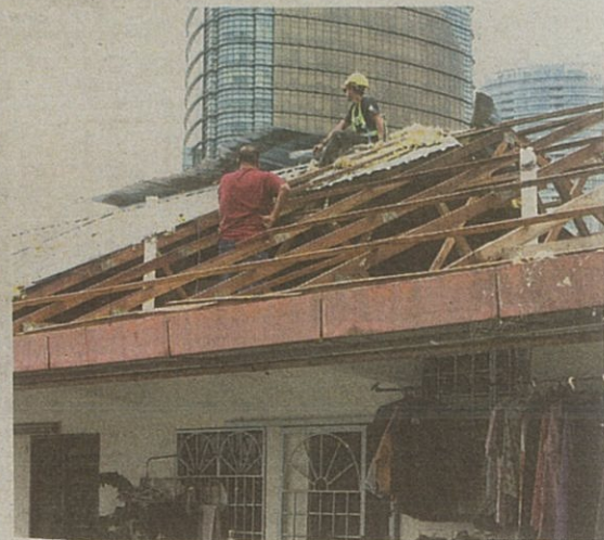
Kerja membaik pulih bumbung yang tercabut di Blok 94, Apartmen Putra Ria Bangsar susulan kejadian ribut dan hujan lebat, kelmarin.
