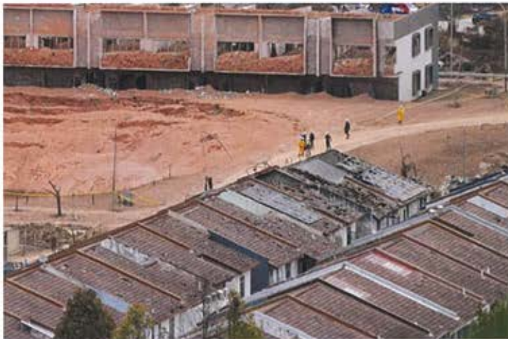
Hanya kediaman yang mengalami kerosakan kurang daripada 20 peratus dalam insiden kebakaran dan letupan saluran gas di Putra Heights, Subang Jaya akan dibenarkan untuk dihuni kembali. Foto Bernama
