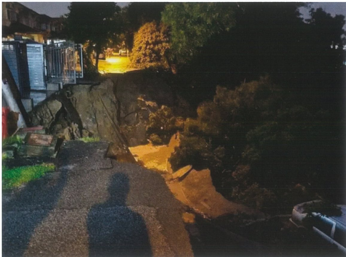
Keadaan tanah runtuh yang turut menyebabkan kerosakan sebuah kereta yang diletakkan di hadapan rumah di Taman Wawasan 3, Puchong pada 16 Disember 2023. Foto Facebook Ng Sze Han
