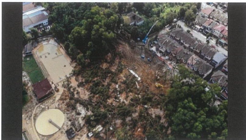
Pada 16 Dis 2023, kejadian tanah runtuh melibatkan kawasan longkang monsun sedia ada dan cerun di kawasan tersebut berlaku susulan intensiti hujan yang sangat tinggi, 95.5 mm. - Gambar Bernama
