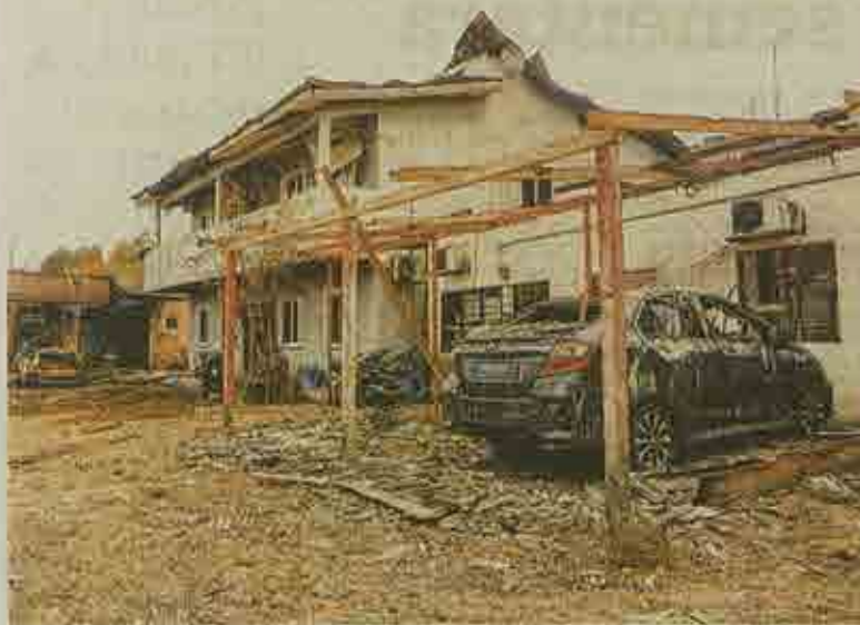
KEBAKARAN saluran paip gas di Jalan Putra Harmoni, Putra Heights, Subang Jaya pada Selasa lalu, menyebabkan penduduk mengalami kerugian besar ekoran kemusnahan harta benda.
