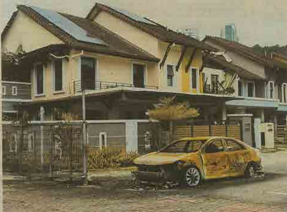
KEADAAN terkor rumah dan kenderaan di Jalan Putra Harmoni, Putra Heights, Shah Alam yang terjejas akibat insiden kebakaran paip gas. - Gambar: NSTP/HAZREEN MOHAMAD
