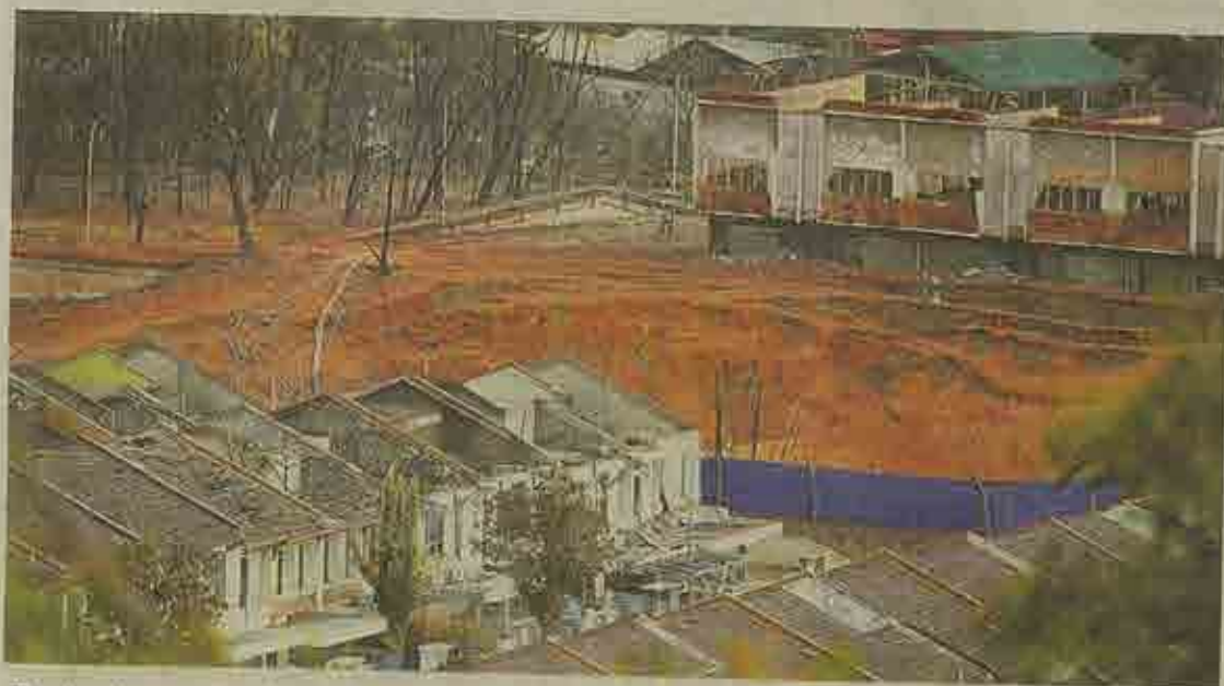
Keadaan kawasan insiden kebakaran saluran paip gas ketika tinjauan fotoBernama di Jalan Putra Harmoni, Putra Heights, pada Ahad.
