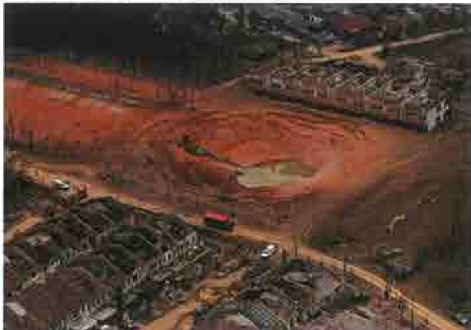
Kawasan projek pembangunan sekitar projek di Jalan Putra Harmoni. Foto diambil oleh pegawai kakitangan 12 (menghimpun) pada 7 April 2025. Foto BERNAMA
