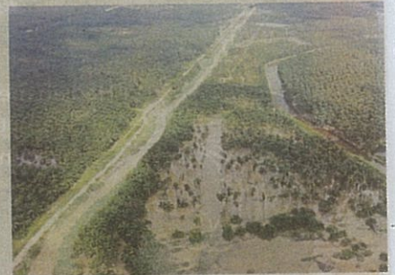
Keadaan kebun penduduk yang dilanda banjir termenung akibat ban pecah dan lambakan sampah di Jambatan Bukit Mayong, Kuala Selangor.
